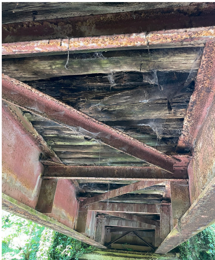
Slika 11: Primarna jeklena konstrukcija.
