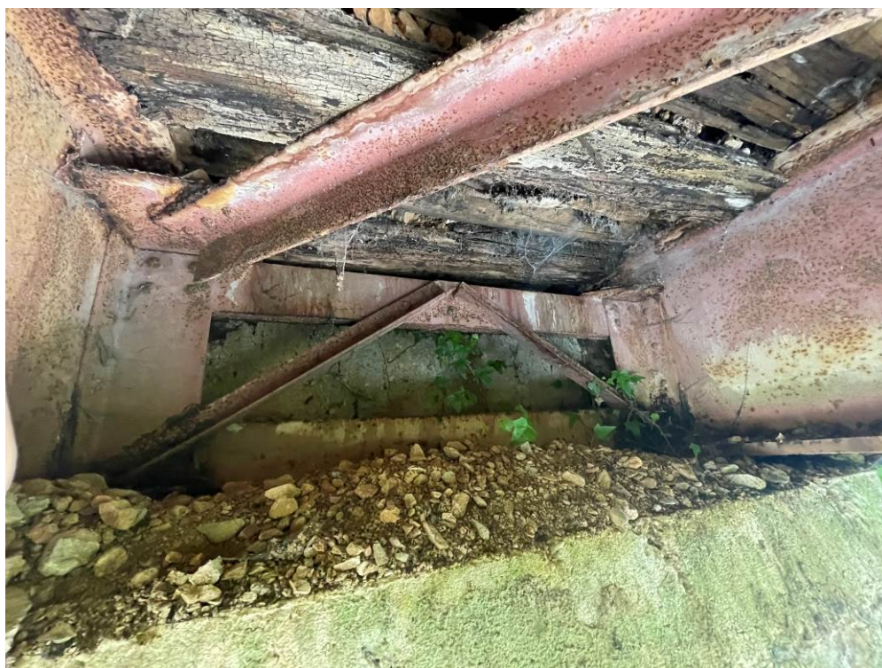
Slika 12: Krajno povezje primarnih jeklenih nosilcev – desni breg.
