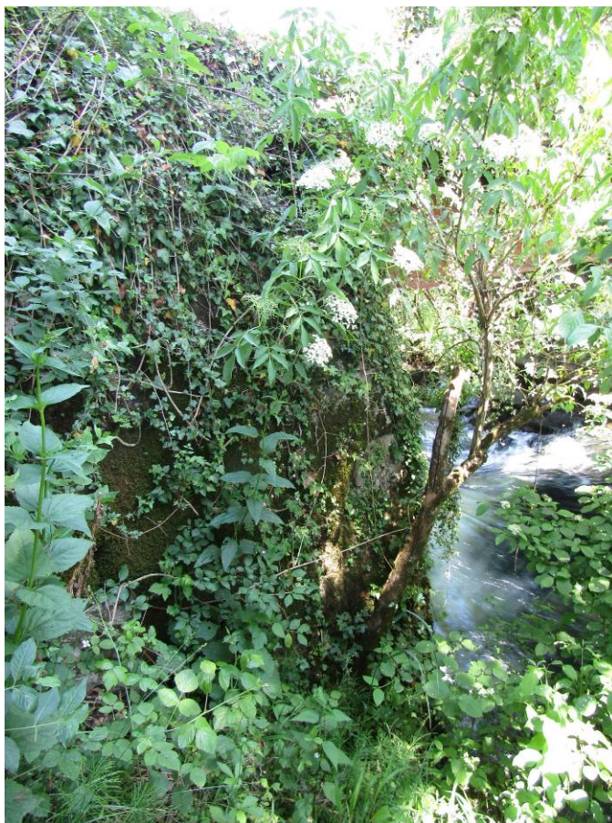
Slika 9: Intenzivna zaraščenost opornika na desnem bregu, ki onemogoča detajlni vizualni pregled.
