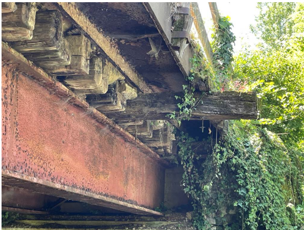
Slika 15: Leseni prečniki ("mostnice") na dol-vodni strani; horizontalno postavljeni robni nosilec HEB 600 podprt z vmesnim lesenim prečnikom.
