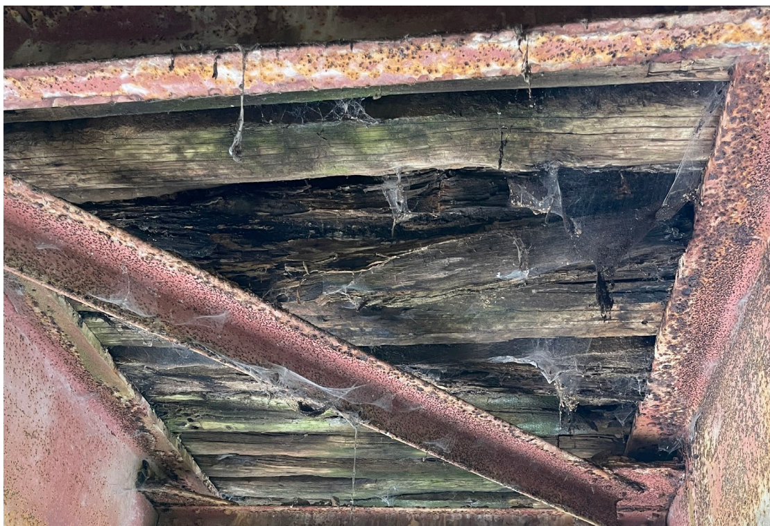
Slika 17: Propadli leseni prečnik na sredini razpona med nosilci.
